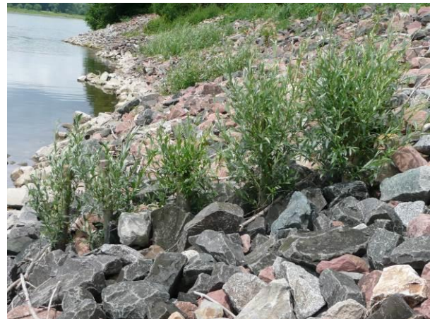
(10) Ausgetriebene Weidensteckhölzer; Juni 2012
