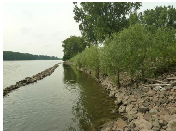
(12) Weiden-setzstangen 2 ½ Jahre nach Bau-fertigstellung; Mai 2014
